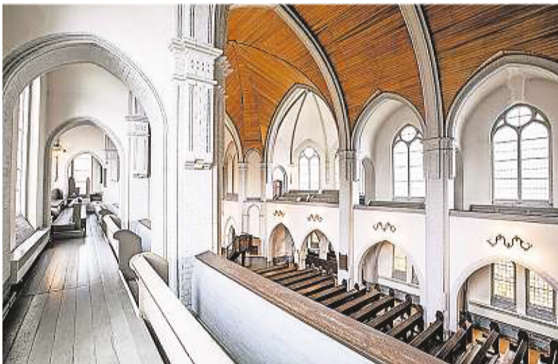
So sah die Kirche vor den Bauarbeiten von innen aus. Die Kirchenbänke mussten mittlerweile bereits weichen.
