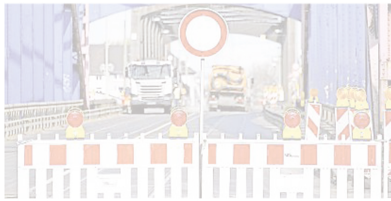
Wegen Asphaltarbeiten war die Karl-Lehr-Brücke gesperrt.
