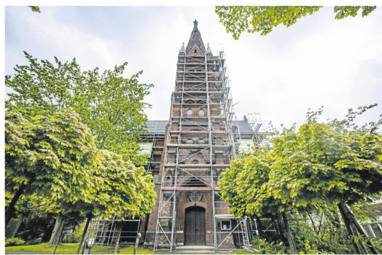
Das Dach der Rheinkirche wird momentan noch saniert. Eine große Aufgabe: Die Balken waren durchgefault. FOTO: VOLKER HEROLD / FUNKE FOTO SERVICES
