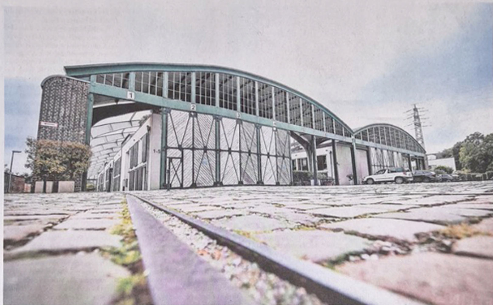
Die Wilde 13 im Hinterhof an der Siegburger Straße 70 ist ein Musterbeispiel für den Mix aus Altem und Neuem.
