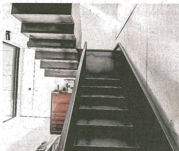
Mit Schwung geht es in den ersten Stock über eine schwarze Stahlterrasse.
