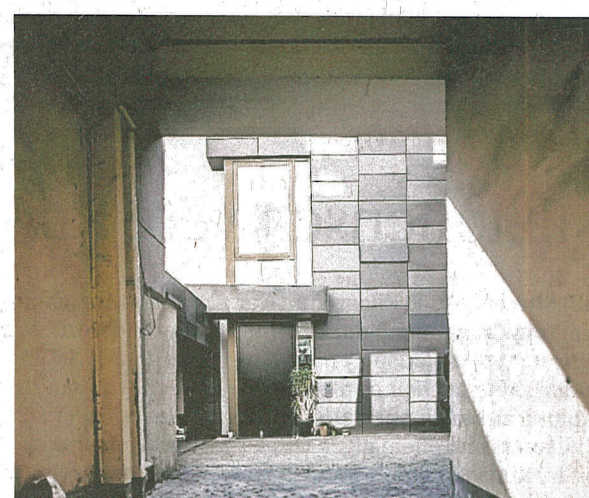
Schwarz und verschlossen – so wirkt die Fassade aus großformatigen Fliesen.
